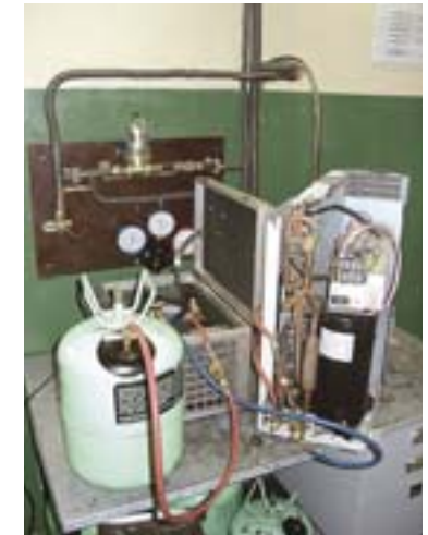
Эвакуация хладагента с помощью вакуационной станции
