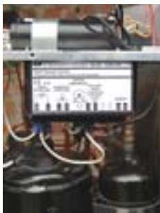
Таким образом устанавливается замедлитель
