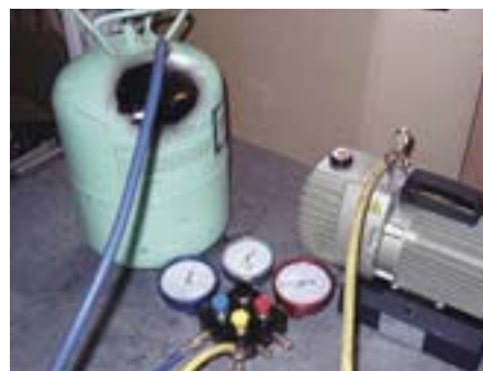
Вакуумирование баллона вакуумным насосом фирмы «REFCO» через манометрический коллектор
