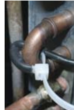
Фото 3. При данном варианте установки нет хорошего контакта сенсора с теплообменником
